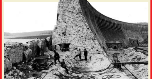
Muldenberg – Explosion an der Staumauer
