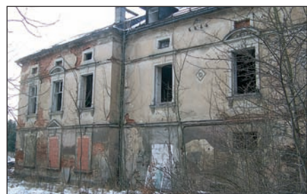
Abrissreifes Herrenhaus des Rittergutes Straßberg (2014), von 1893 bis in die 1930er-Jahre im Besitz von Carl Adler. P&K
