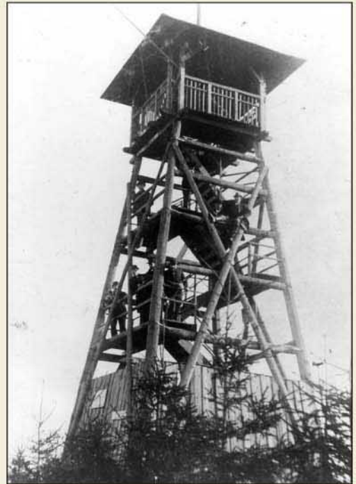
Der Witterung nicht gewachsen (erster Aussichtsturm auf dem Eisenberg, 1890 - 1897): Die Holzkonstruktion war schon nach wenigen Jahren baufällig geworden.
