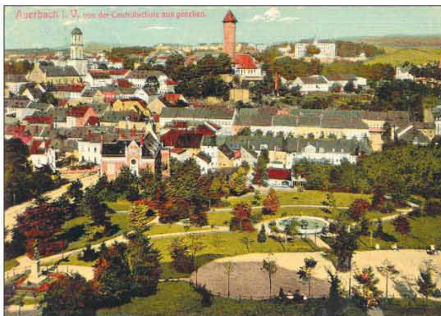
Blick über Auerbach, 1914: Vorn der Goethepark, hoch über den Dächern die Türme der St. Laurentiuskirche (L) und des Schlosses, oben am damaligen Stadtrand das Lehrerseminar.
