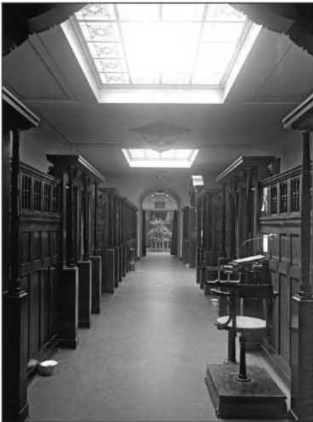
Gediegenes Interieur: der Gang zu den Umkleidekabinen der Sauna. Hinten der Ruheraum, vorn rechts eine Personenwaage, gegenüber ein Spucknapf. Holztafelung bestimmte auch sonst das Bild im Aufenthalts- und Umkleidebereich des Bades.
